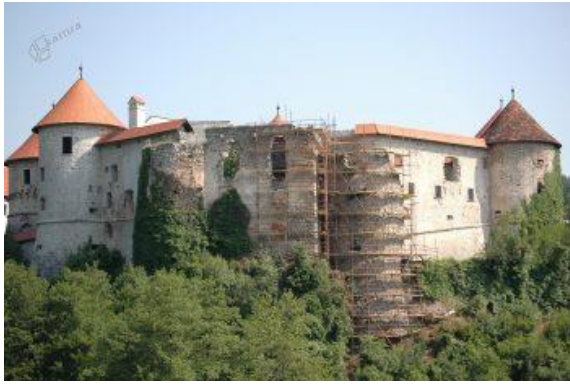
Slika 20: Grad med obnovo [vir: internet]
